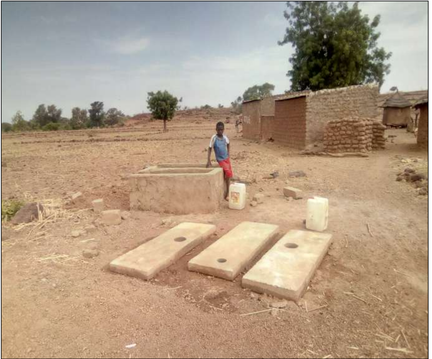
Fabrication de dalles pour les latrines de 2022
