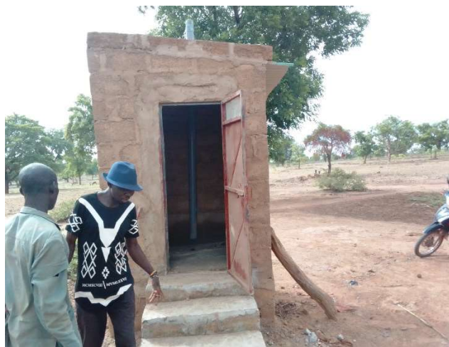
Une latrine 2024 construite
