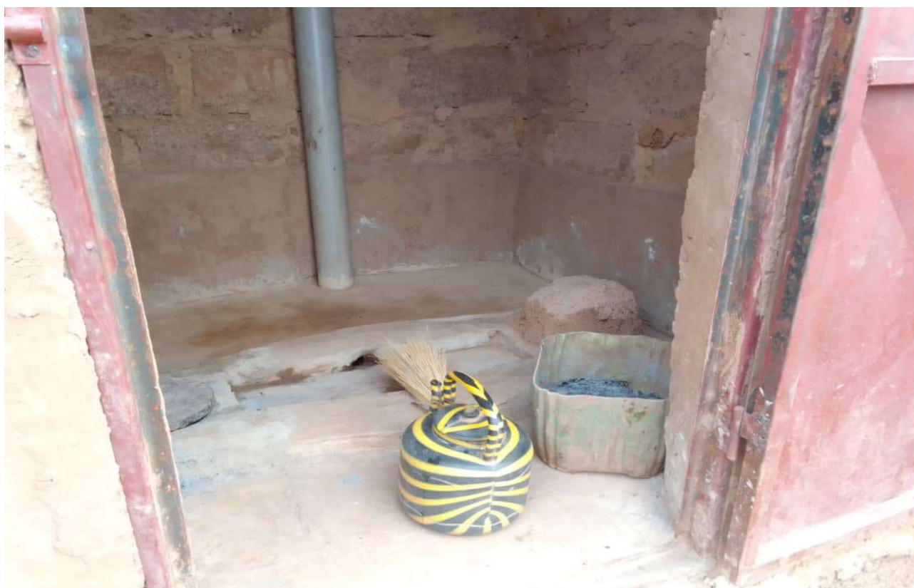
Photo intérieure d'une latrine bien entretenue dans le quartier SOSSO
