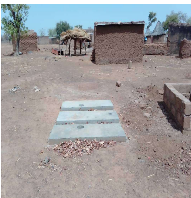
Photo de construction de latrine à l'étape de fixation de porte et de construction de dalles dans le quartier cité
